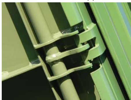
doppelte Pendelwandlager seitlich (ab 5,15m)
